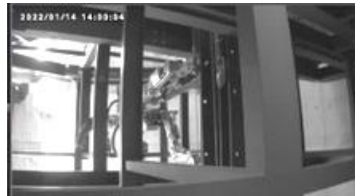
落下防止用の吊具取付
