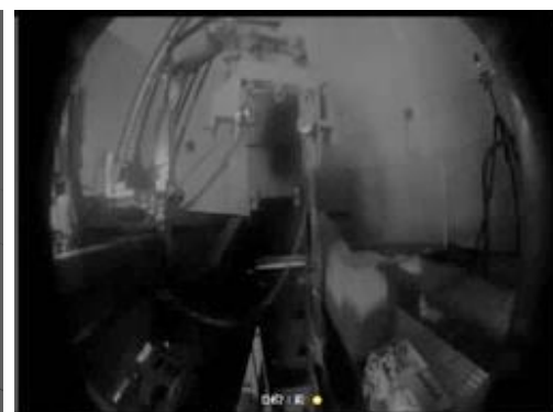
落下防止治具A設置
