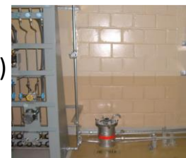
2,3号機: コンクリートブロック (イメージ)
