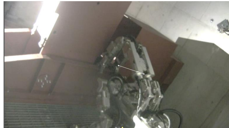
アーム押し付け力による損傷状況確認
