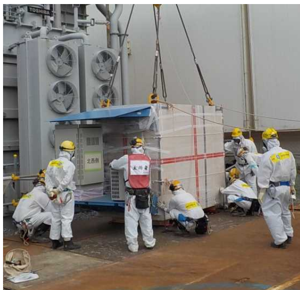
測定装置設置作業風景
