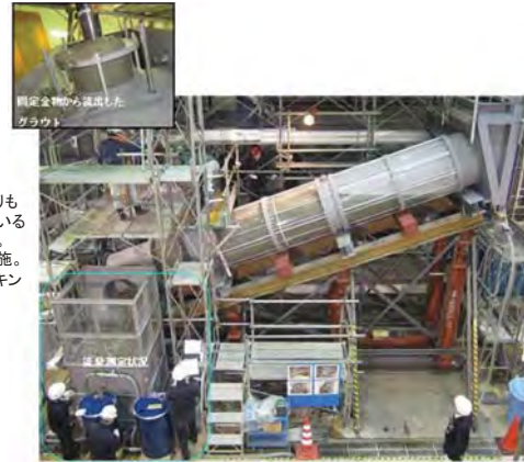
写真12-2 止水材の充填状況
