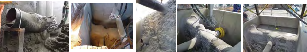
写真30-1 配管周囲の堰構築
